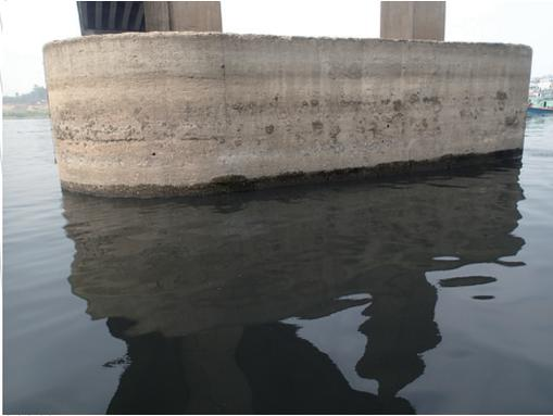
透明度 5 cm程度の河川で、建造時の鋼材の残滓やそれによって生じた不規則な洗堀状況が確認できる。
